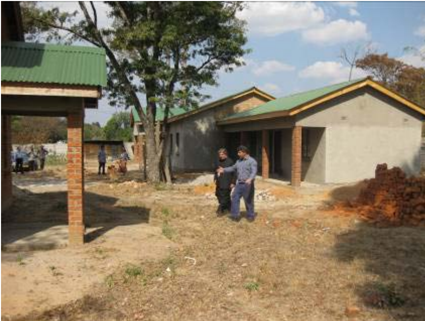
Η υπό ανέγερση κλινική στο Ιεραποστολικό Κέντρο Αγίου Γεωργίου
